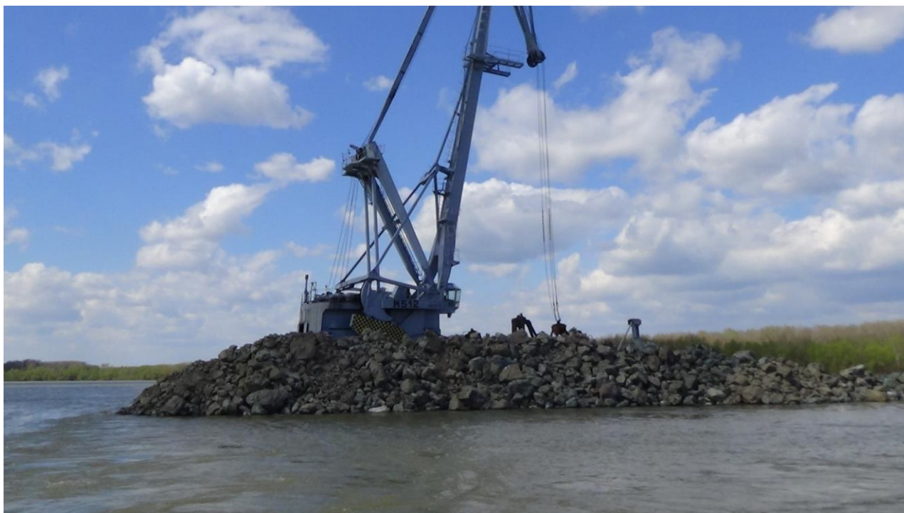
Figura nr. 2.1.2 - Macara staționară în zona zona Insula Epurașu
