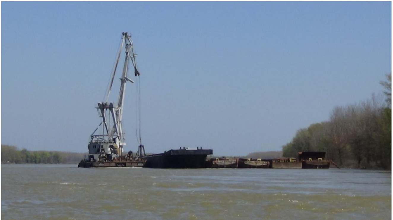
Fig.2.1.1. -Macara plutitoare, pe malul stâng în zona Bala
