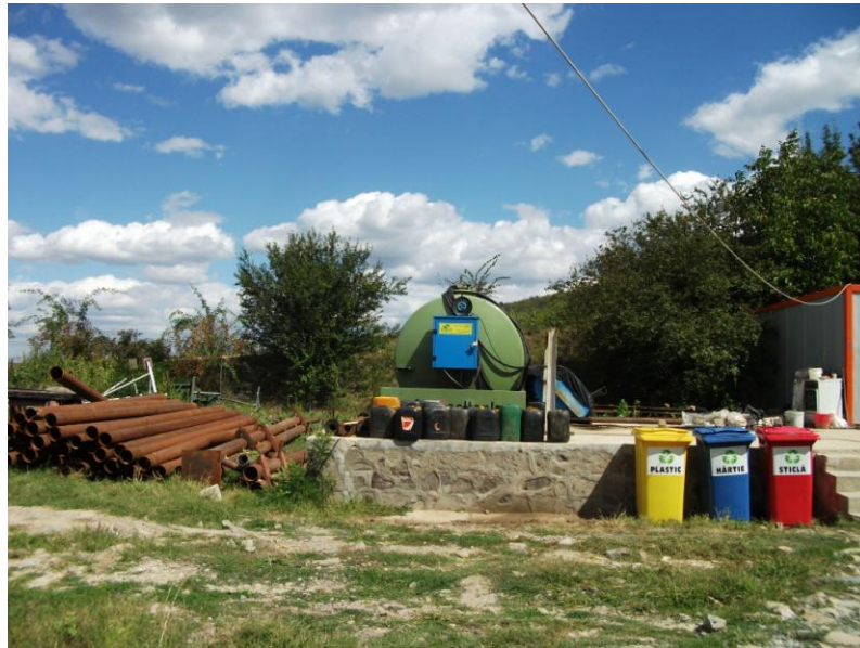
Foto 1 - Zona de depozitare a carburanților, uleiurilor uzate și deșeurilor menajere
